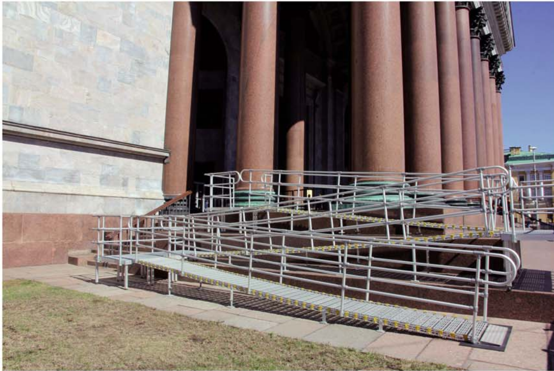
Bild links: Isaaks-Kathedrale, St. Petersburg Rampenlänge: 22,9 m Podest: 7,5 m Breite: 91,4 cm Höhe: ca. 1,9 m Die Rampe ist 2-fach an der Kathedrale aufge- baut, einmal vorne am Eingang (Bild) und ein zweites Mal an der Rück- seite der Kathedrale. Sie ist eine „mobile Rampe“, die auf Wunsch umge- staltet oder an anderer Stelle aufgebaut werden kann. Diese Rampe ist derzeit eine der größten im Roll-A-Ramp System.
